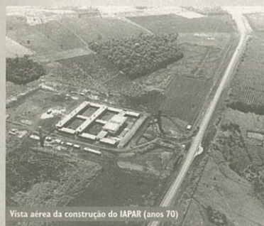
Vista aérea da construção do IAPAR (anos 70)
